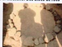
Fig. 7. Fondation du socle
