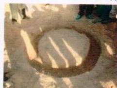
Fig. 6. Fouille de la fondation
