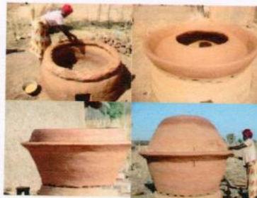
Fig. 11. Étapes de construction du corps du GTA de type Monkolé
