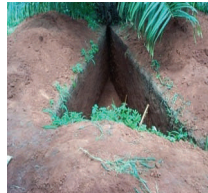
Fig. 4 C : Fosse de 1,7 m excavée pour prélever les racines
